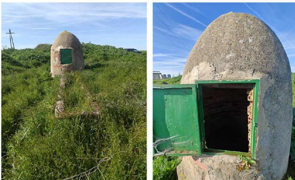
Figura 13. Detalle del pozo del abrevadero. Estructura completa (izquierda), acceso al pozo (derecha).
