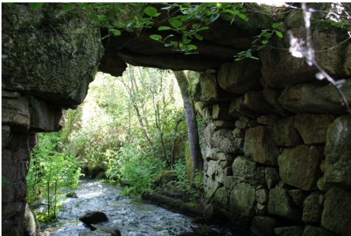
Estado actual da ponte Pontón Vello
