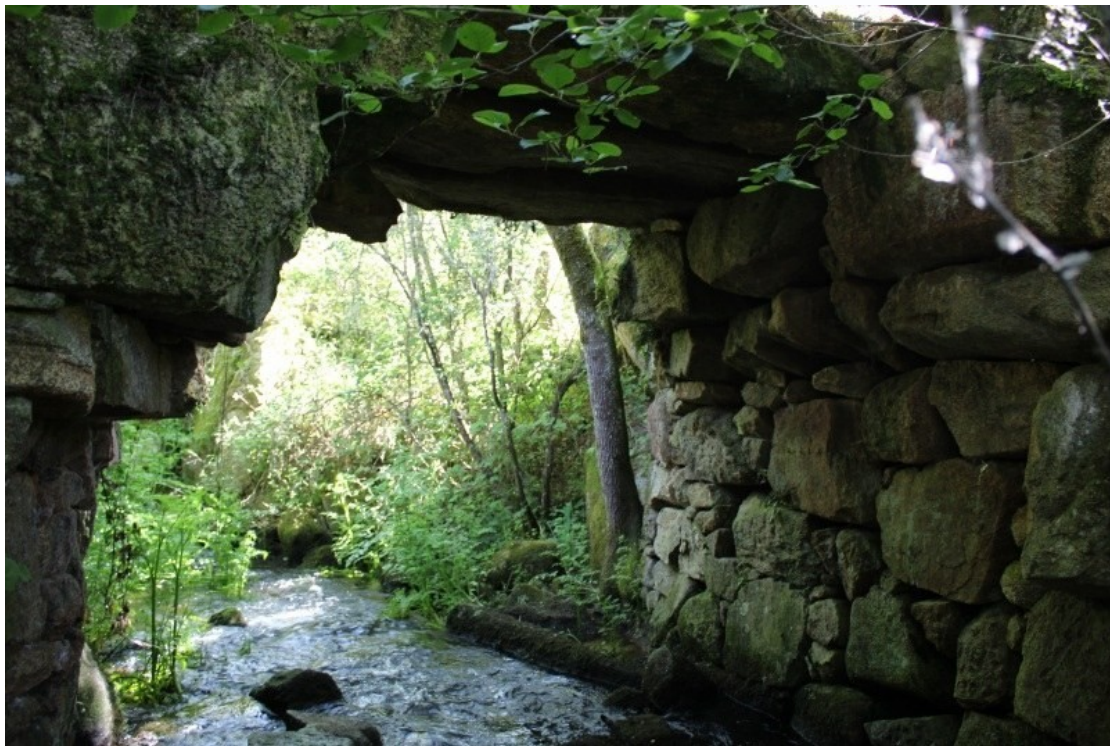
Estado actual del puente Pontón Vello
